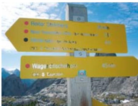
Farbschäden an den neuen Wegweisern: Da die Schrift zusätzlich ausgefräst ist, bleibt die Lesbarkeit einigermaßen erhalten.
